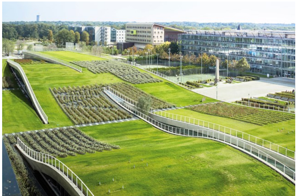
Un exemple de toit végétal de type extensif et semi intensif en France
